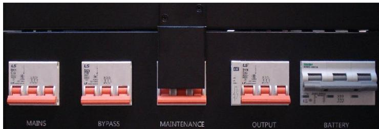
Abb. 3-16 Die Leitungsschutzschalter der USV-Anlagen (30 / 40 kVA) gekennzeichnet von links nach rechts mit:
