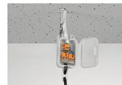
Anschluss von Pendelleuchten in abgehängten Decken
